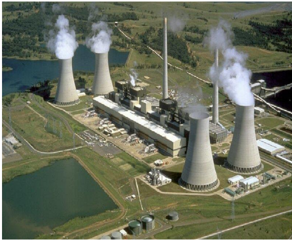
Issiqlik elektr stantsiyasi
